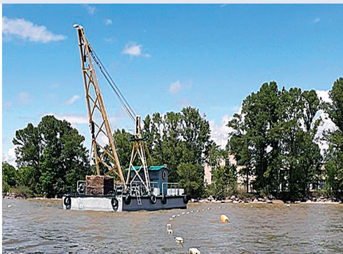
Проведення підводно-будівельних робіт з водозабору ГНС Вищетарасівської зрошувальної системи НМУВГ
