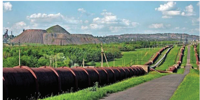
Мережа трубопроводів каналу «Сіверський Донець-Донбас»
