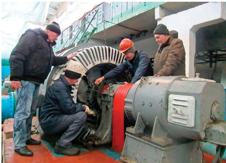
Ремонт насосно-силового обладнання
