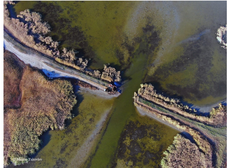
Демонтаж та розчистка гребель в дельті річки Дунай
