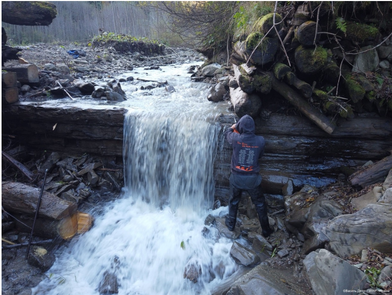
Демонтаж гребель в басейні р. Черемош
